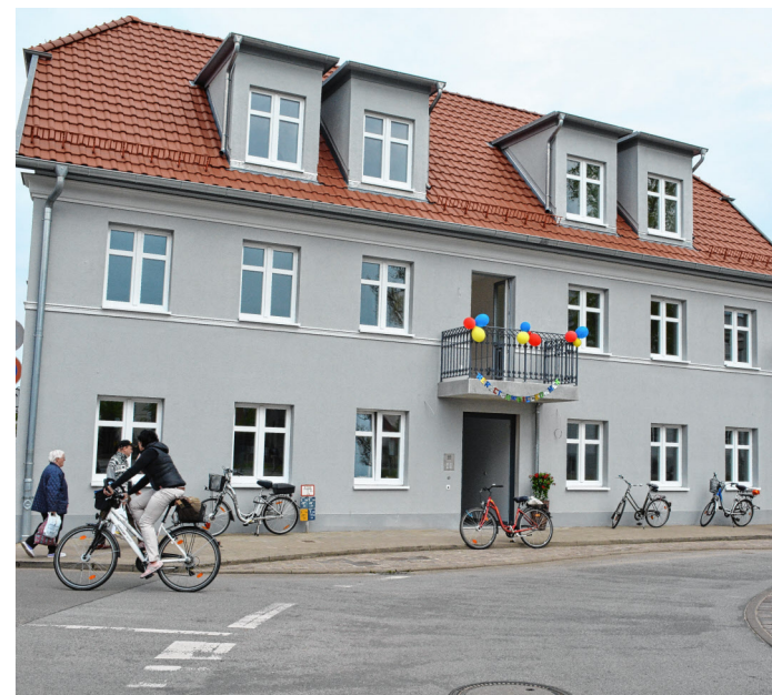
Das Haus Kießerdamm 13 erwartet bald die neuen Mieter.
